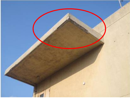
老朽施設の庇（経年 39 年）
