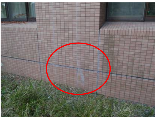
老朽施設の外壁（経年 19 年）
