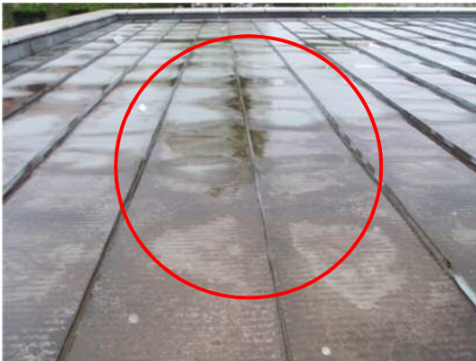
老朽施設の金属屋根（経年 16 年）
