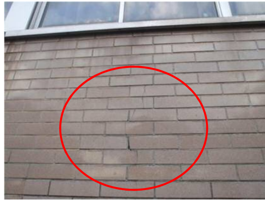
老朽施設の外壁（経年 52 年）
