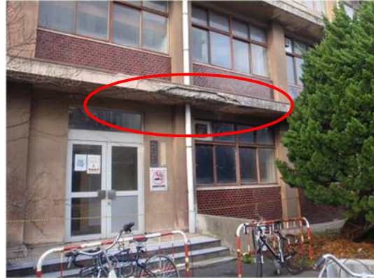
老朽施設の庇（経年 49 年）
