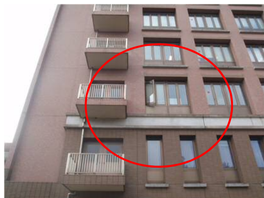
老朽施設の外壁（経年 18 年）
